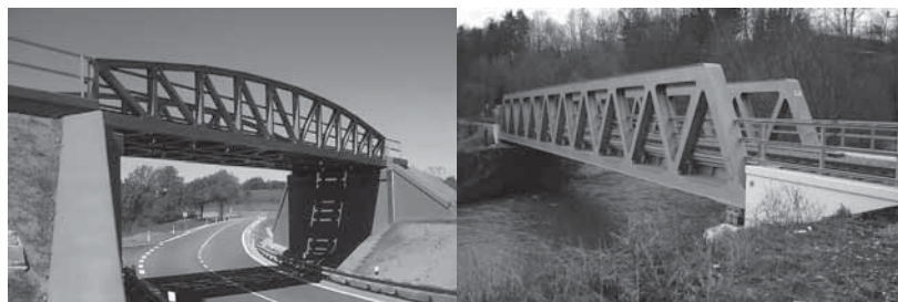
Fig 3 și 4. Exemple de structuri triunghiulare de pod. Sursa: Railway bridges. Top Con Service [online]. 1992-2011 [cited. 02.19.2012]. Disponibil la: http://www.topcon.cz/reference/railway-mosty.htm
